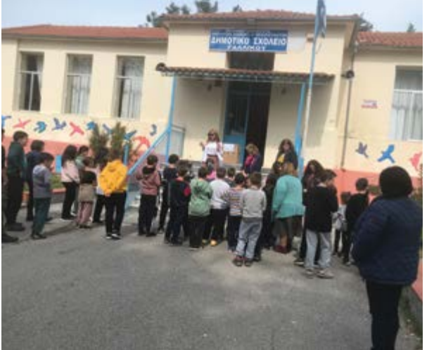
Δημοτικό Σχολείο Γαλλικού
